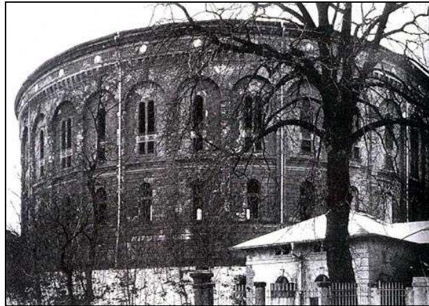
Gasometro di Dresda convertito in albergo.
