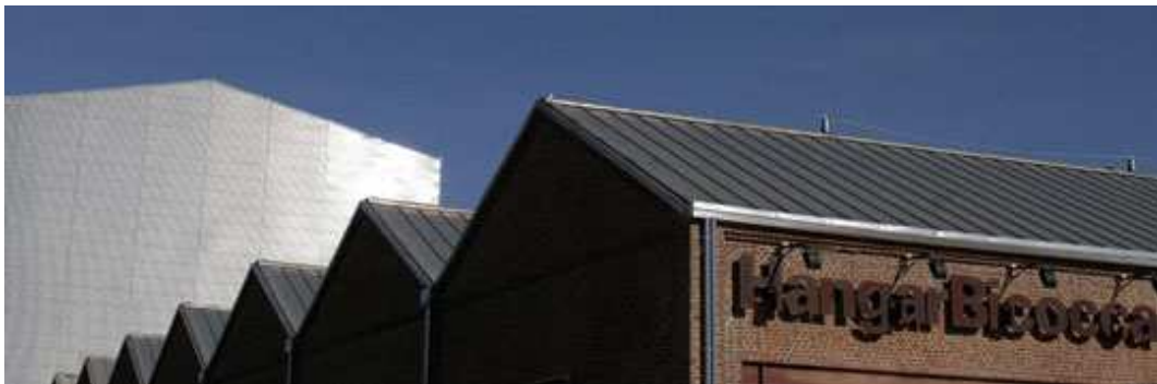
Hangar Bicocca, particolare esterno (foto: © Hangar Bicocca)
